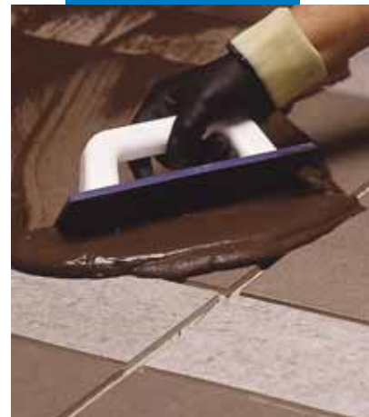
Rozprowadzanie zaprawy Ultracolor Plus na podłozie przy użyciu gumowej pacy
