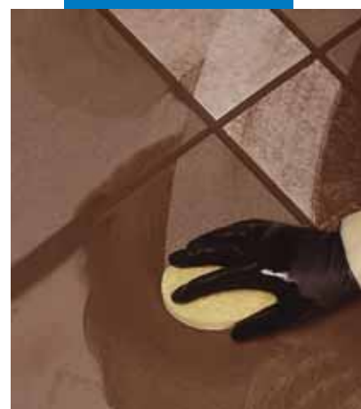
Czyszczenie i profilowanie fug gąbką
