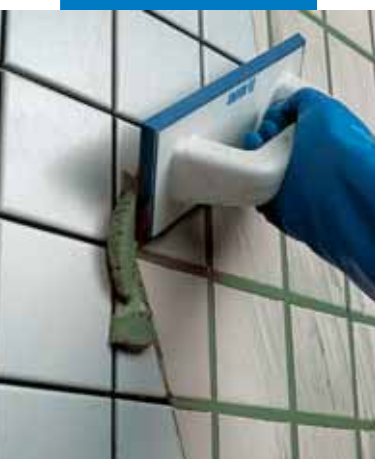
Nanoszenie zaprawy Ultracolor Plus pacą gumową na ścianie
