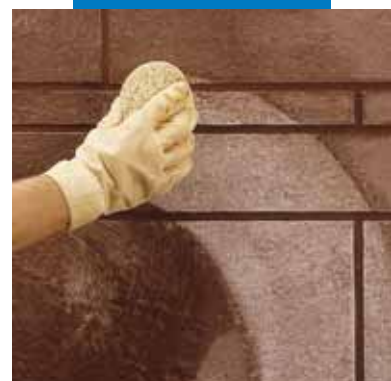
Czyszczenie i profilowanie fug gąbką
