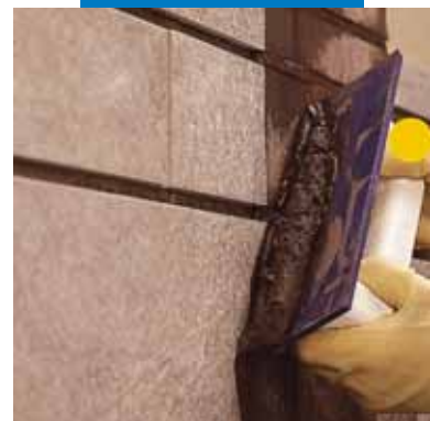
Nanoszenie zaprawy Ultracolor Plus przy użyciu pacy gumowej
