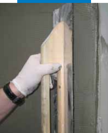
Wyrównywanie warstwy zaprawy Mapetherm do siatki z zatopioną siatką szklaną
