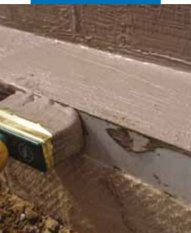
Hydroizolacja ścian pionowych z użyciem Mapeproof PL i Mapelastíc Foundation
