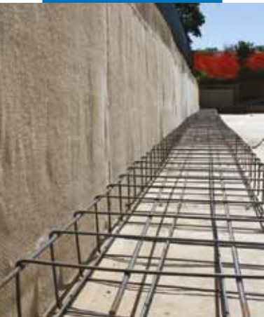
Hydroizolacja płyty dennej
