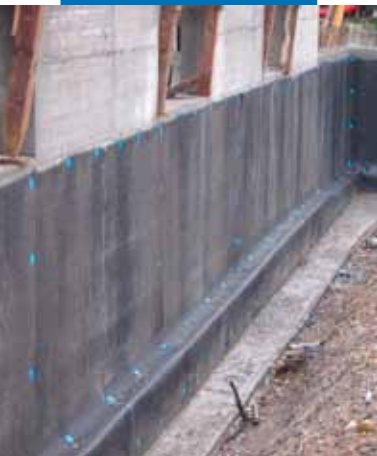
Hydroizolacja powierzchni pionowej z użyciem Mapeproof PL
