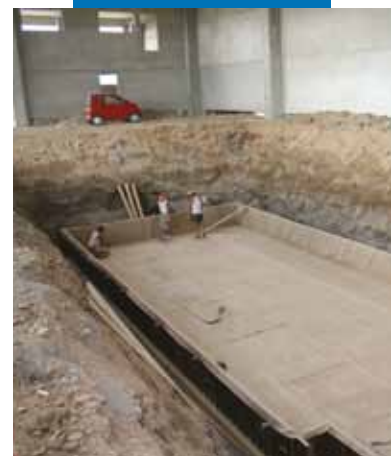
Hydroizolacja powierzchni poziomej z użyciem Mapeproof PL
