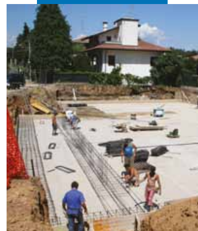
Hydroizolacja fundamentów budynku
