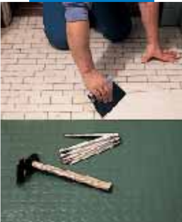
Rozprowadzanie Adesilex G19 przy użyciu szpachli
