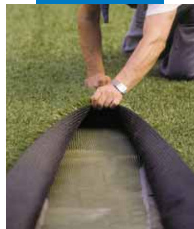
Montaż trawy syntetycznej na Adesilex G19 - Stadion S. Siro - Mediolan
