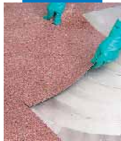
Montaż wykładziny PVC przy użyciu Adesilex G19
