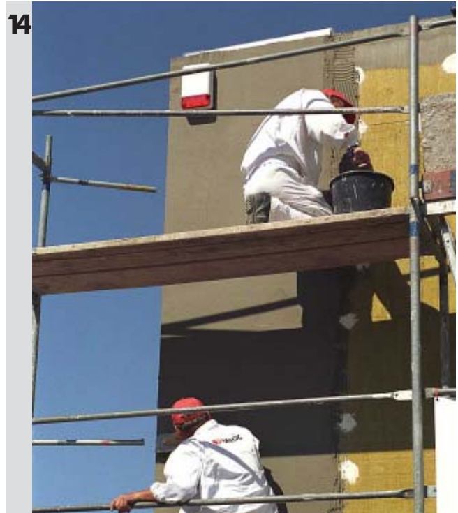
Dokładne wyrównanie powierzchni zaprawą
