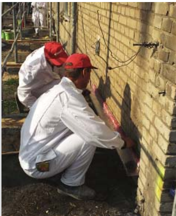
Dokonanie obmiarów profilu cokołowego
