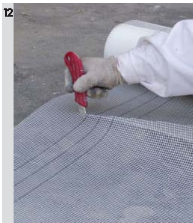
Przycięcie siatki zbrojącej z włókna szklanego
