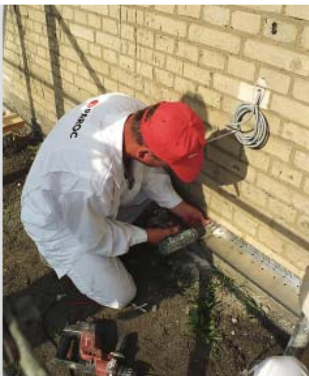
Mocowanie profilu cokołowego
