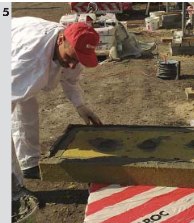
Nakładanie zaprawy na płytę - około 40% jej powierzchni
