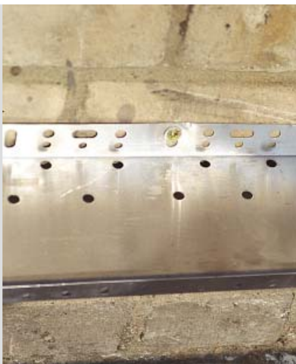
Detal - łączenie profili cokołowych
