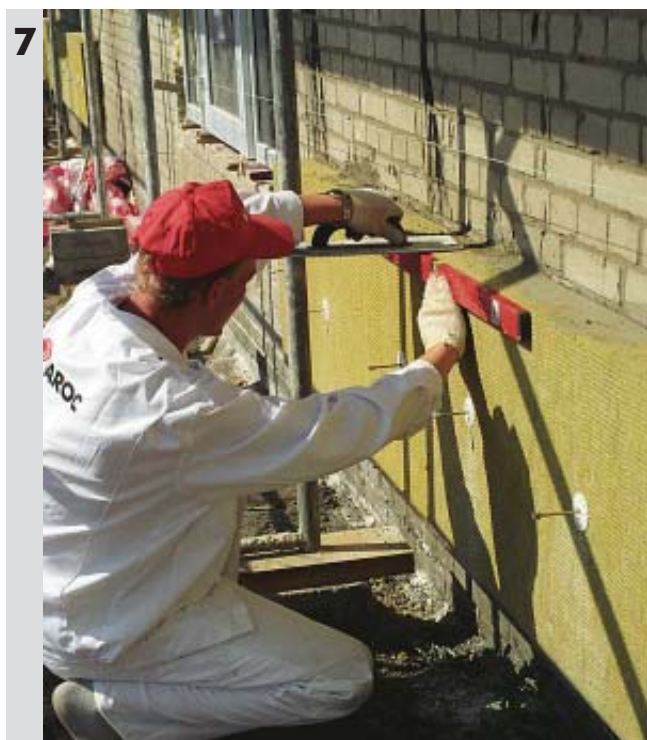
Kontrola pionów i poziomów przyklejonych płyt
