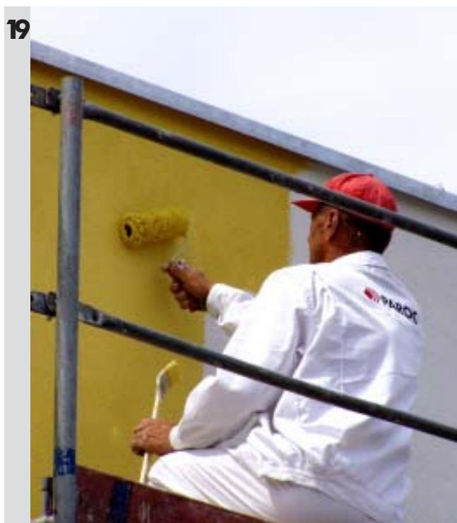
Malowanie wyschniętego tynku
