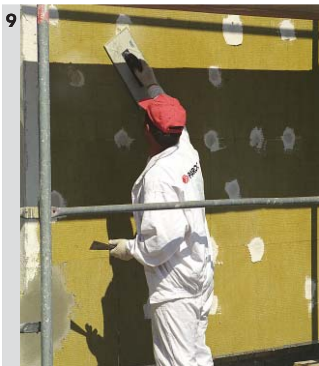
Przetarcie płyt tarka tak aby zniwelować nierówności np. po przespachlowanych kapturach łączni
