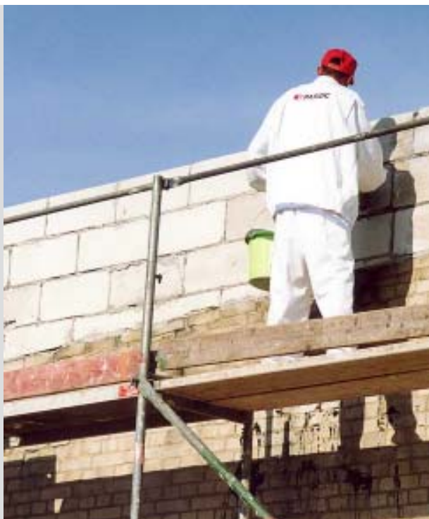
Przygotowanie podłoża - usunięcie nierówności i zagruntowanie, jeśli jest to konieczne
