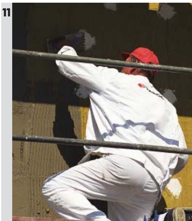
Naniesieni zaprawy na płyty
