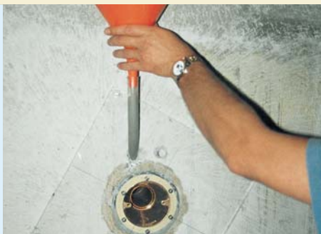
Zalewanie nieszczelnych lub dodatkowo wbudowanych dysz PCI Apoten®.
