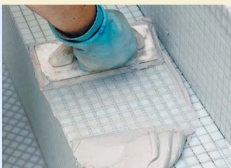
Spoinowanie okładzin ściennych i posadzkowych trudno ścieralną zaprawą żywiczną PCI Durapox® NT/NT plus.
