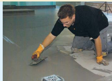
Naniesienie elastycznego szlamu PCI Seccoral®. Po wyschnięciu warstwy gruntującej nanoszonej na matowo wilgotne podłoże, nanosi się metodą szpachlowania minimum dwie kolejne warstwy.
