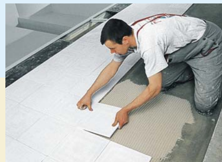
Wyklejanie wielkoformatowej ceramiki za pomocą PCI Nanolight®.
