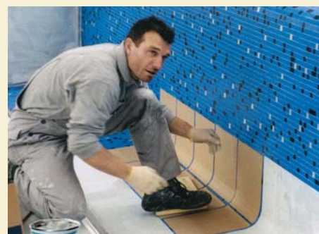
... płytki i płyty uzyskują pewną przyczepność na stali i poliestrze.
