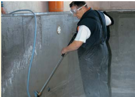
Przygotowanie podłoża betonowej niecki basenowej przez hydromonitoring lub piaskowanie.
