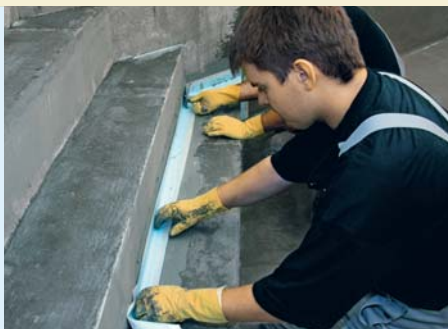
Wklejenie taśmy uszczelniającej PCI Pectitape® 120 w świeżo naniesione uszczelnienie PCI Seccoral®.
