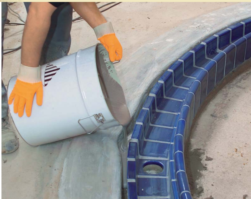
Wypełnienie przestrzeni pomiędzy rynną przelewową a warstwami konstrukcyjnymi plaży basenu za pomocą zaprawy żywicznej PCI Apoten eliminuje podciąganie kapilarne wody prowadzące do szkód i usterek.
