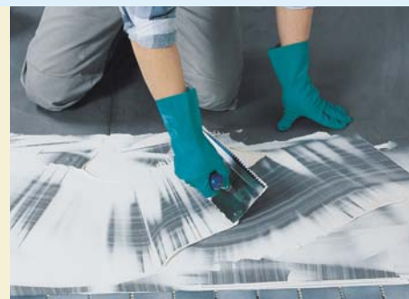
Przy użyciu plastycznego kleju do płytek na bazie żywicy reakcyjnej PCI Collastic® ...
