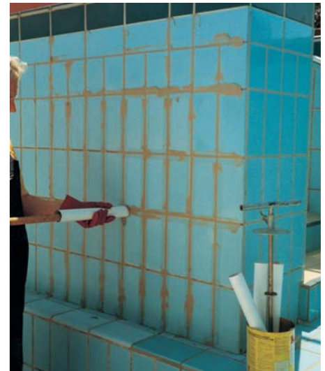
Starsze spoiny cementowe, które są uszkodzone, można ponownie zaspoinować zaprawą PCI Durapox ® NT/NT plus. Wystarcza przy tym głębokość spoiny wynosząca co najmniej 3 mm.
