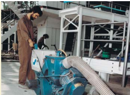
Bezpyłowe przygotowanie dna niecki basenowej przez blastrakowanie.
