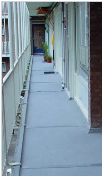
Loggia z powłoką epoksydową
