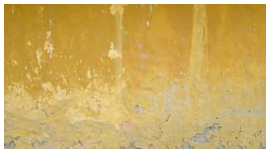
Degradacja tynku.
