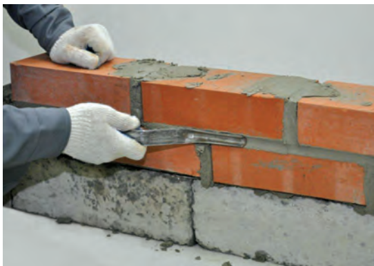
Fot. 28 Wygładzanie spoiny kielnią półokrągłą.
