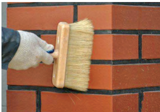
Fot. 31 Czyszczenie pędzlem na sucho.
