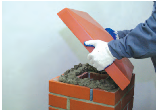
Fot. 22 Montaż czapki na nanozaprawie ALPOL AZ 120-126.
