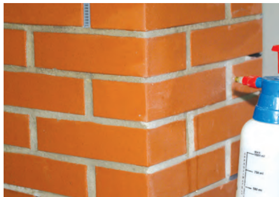
Fot. 36 Nanoszenie spryskiwaczem nanoimpregnatu ALPOL AI 780 .
