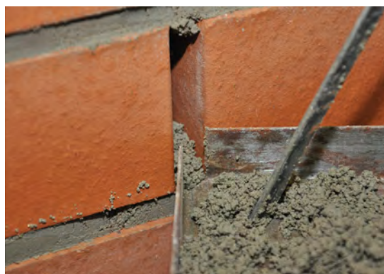
Fot. 28 Wygładzanie spoiny kielnią półokrągłą.
