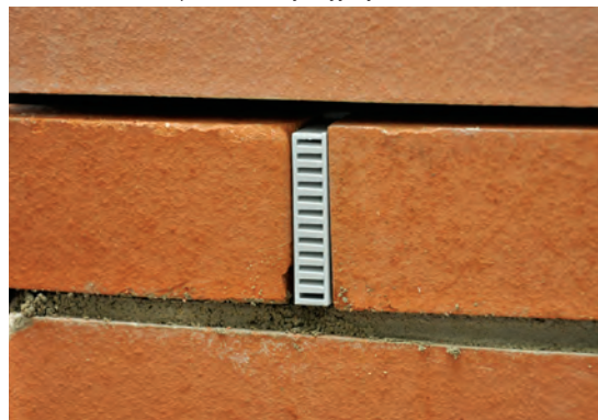
Fot. 14 Montaż puszek wentylacyjnej w murze.
