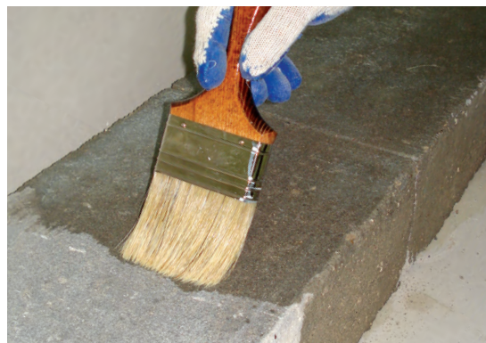
Fot. 6 Malowanie gruntem ALPOL AG 707 .
