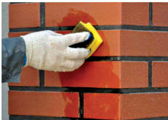
Fot. 32 Czyszczenie gąbką na mokro.
