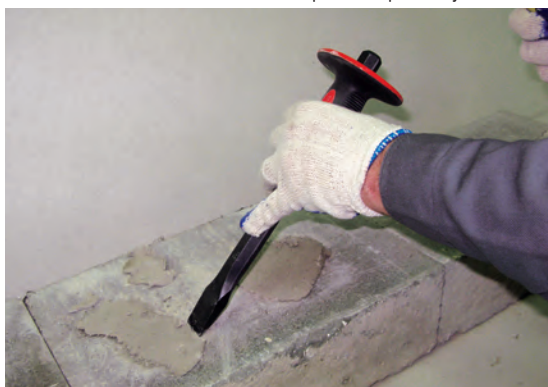
Fot. 3 Usuwanie nierówności na podłożu poziomym.
