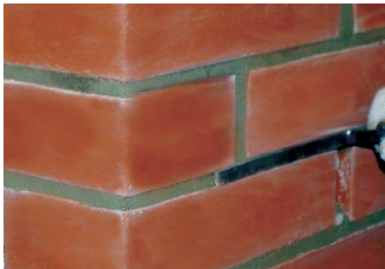
Fot. 27 Wygładzanie spoiny kielnią płaską.
