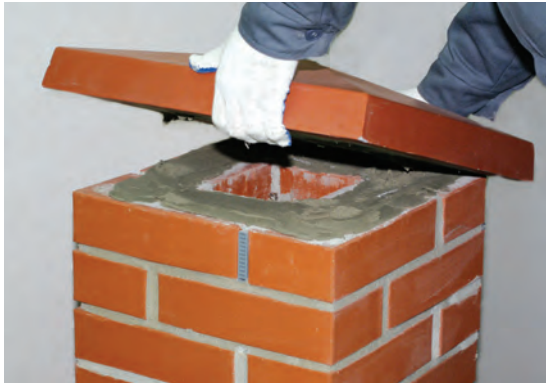
Fot. 21 Montaż czapki na nanokleju ALPOL AK 518.
