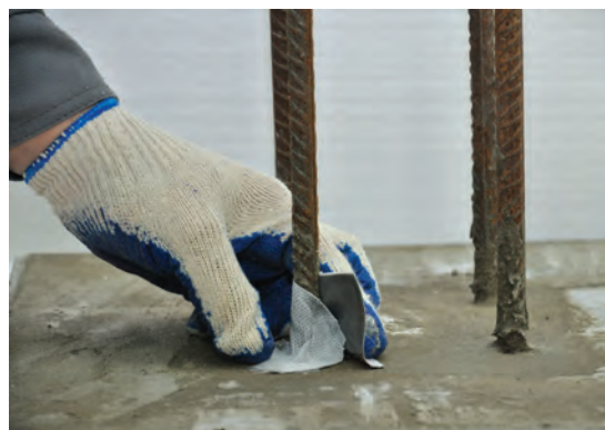
Fot. 8 Naklejanie taśmy butylowej ALPOL TB 100 .
