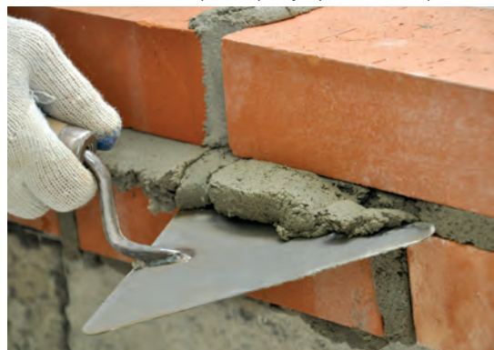
Fot. 10 Murowanie na pełne spoiny – podcinanie zaprawy.
