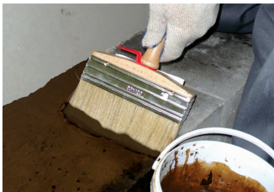
Fot. 5 Malowanie emulsją ALPOL AH 740 .
