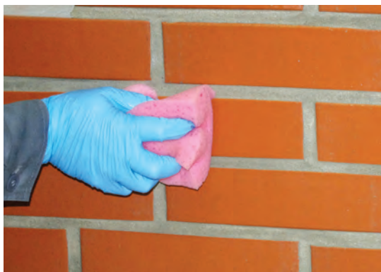
Fot. 34 Szorowanie powierzchni czyścikiem ALPOL AI 770.
