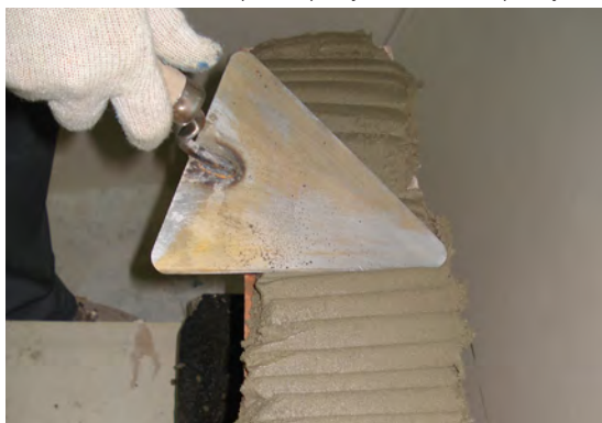
Fot. 9 Murowanie na pełne spoiny – układanie zaprawy.
