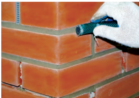
Fot. 29 Wygładzanie spoiny rurką.
