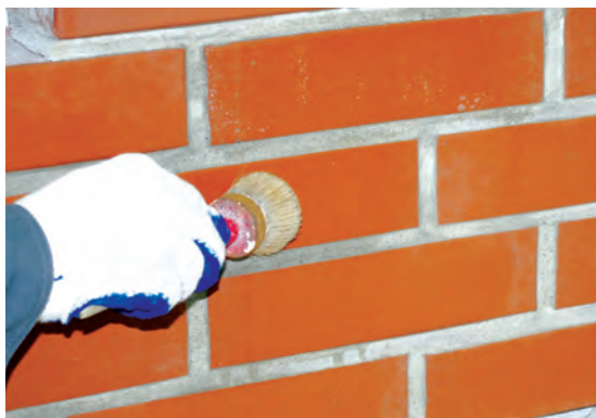
Fot. 33 Nanoszenie pędzlem czyścika ALPOL AI 770.
