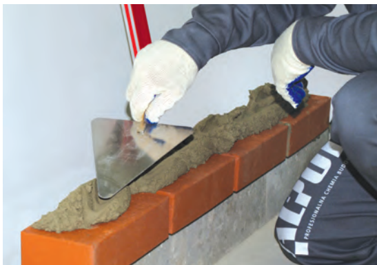
Fot. 11 Murowanie na puste spoiny – układanie zaprawy.
