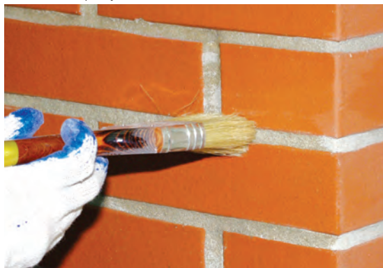
Fot. 35 Nanoszenie pędzlem nanoimpregnatu ALPOL AI 780 na spoiny.
