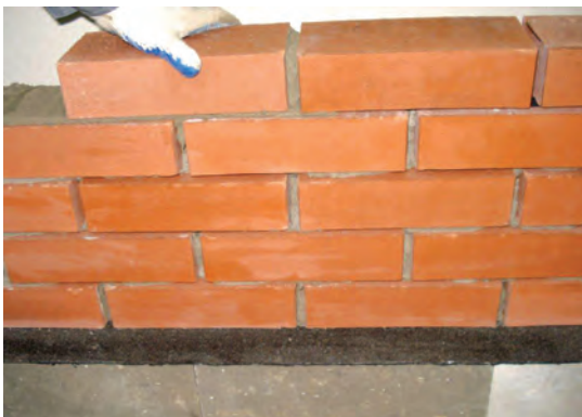
Fot. 12 Murowanie na puste spoiny – murowanie na wycisk.
