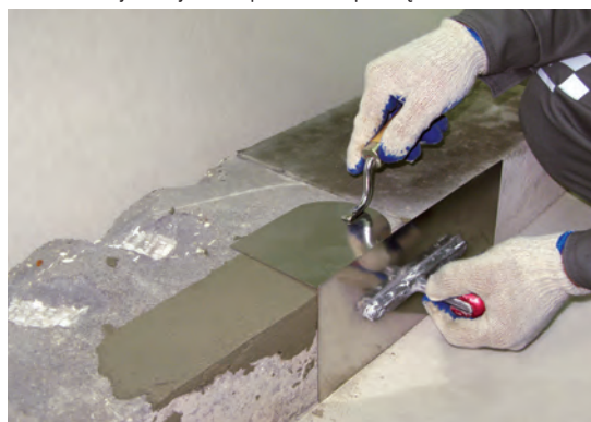
Fot. 4 Wyrównywanie podłoża zaprawą ALPOL AZ 135.
