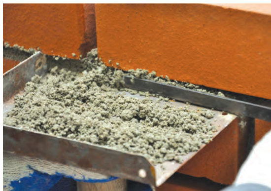
Fot. 27 Wygładzanie spoiny kielnią płaską.
