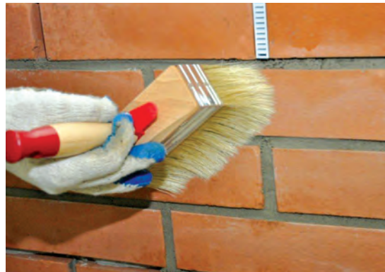
Fot. 30 Czyszczenie muru po spoinowaniu.
