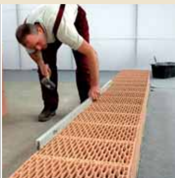
rys. 8. Wyrównanie pustaków w pierwszej warstwie wzdłuż ściany
