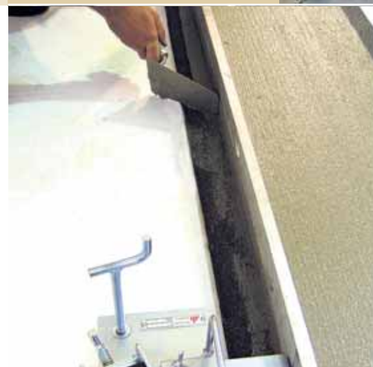
rys. 5. Usunięcie nadmiaru zaprawy
