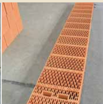
rys. 7. Ułożona pierwsza warstwa muru obwodowego
