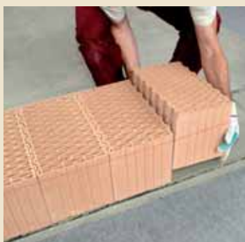
rys. 6. Układanie pierwszej warstwy pustaków
