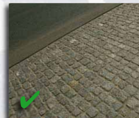
Zatoczka autobusowa po remoncie
